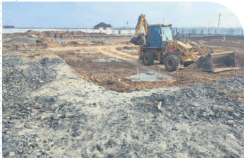
Виктор Ефимович побывал на стройплощадке – здесь вырыт котлован, забиты сваи (в том числе, для усиления грунтов), выполнено устройство бетонной подготовки под ростверки. На днях начнется монтаж
